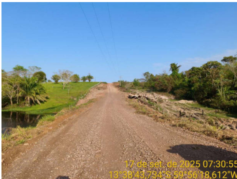
Foto 92 – Trecho não pavimentado da MT-440.
