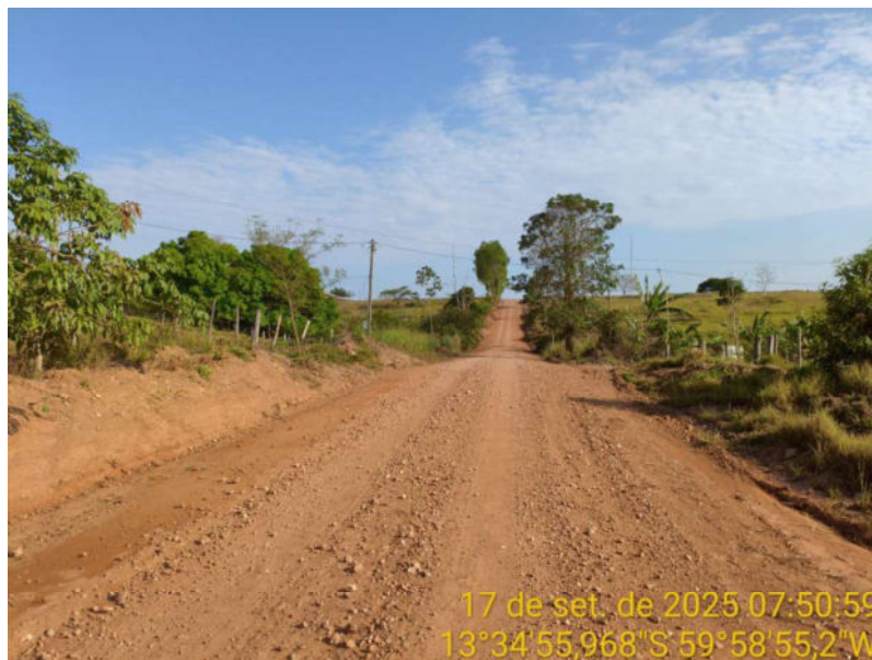
Foto 100 – Trecho não pavimentado da MT-440.
