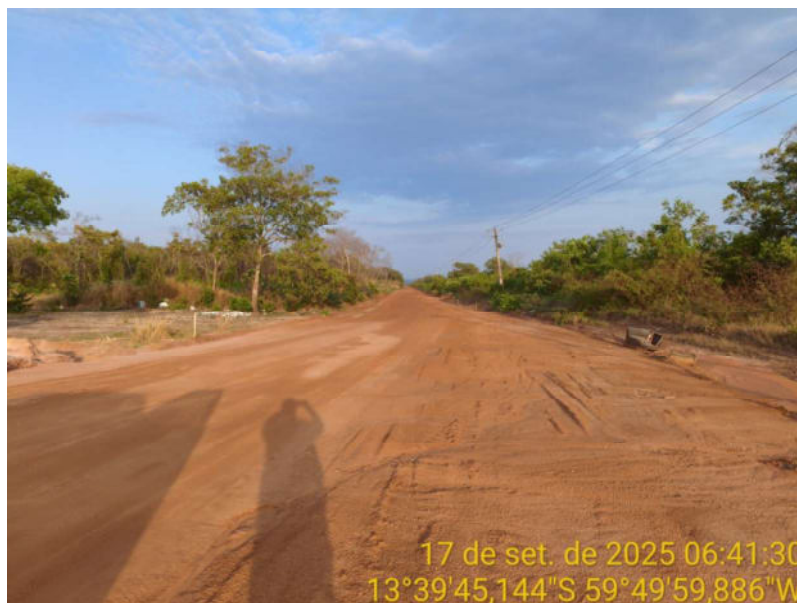
Foto 77 – Início do trecho não pavimentado da MT-440.
