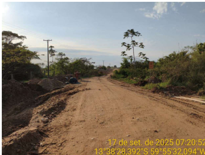
Foto 87 – Trecho não pavimentado da MT-440.
