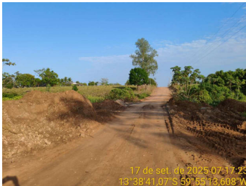
Foto 86 – Trecho não pavimentado da MT-440.
