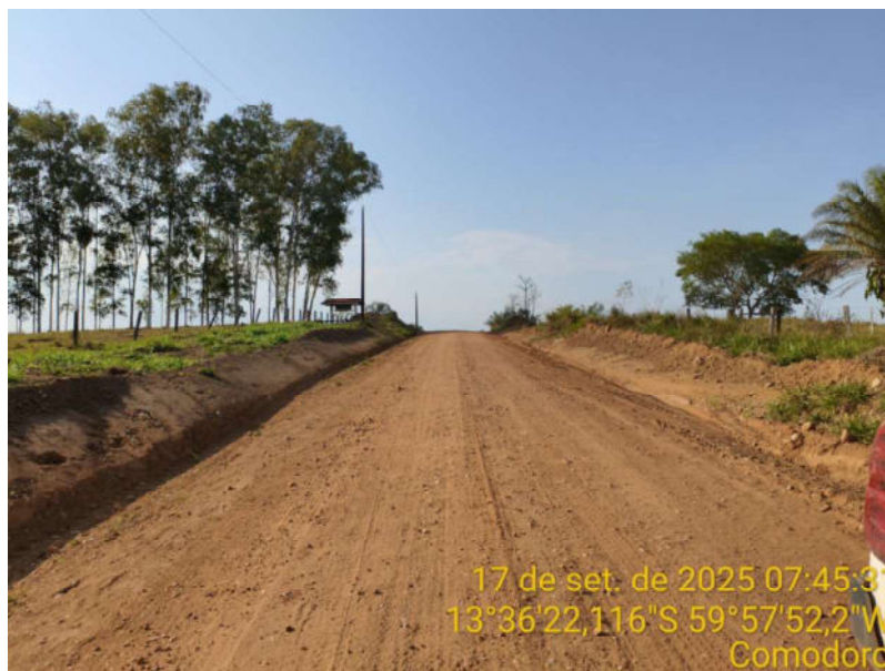
Foto 97 – Trecho não pavimentado da MT-440.
