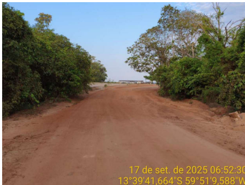
Foto 81 – Trecho não pavimentado da MT-440.
