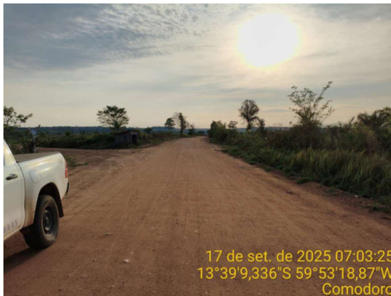
Foto 84 – Trecho não pavimentado da MT-440.
