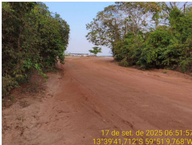
Foto 80 – Trecho não pavimentado da MT-440.
