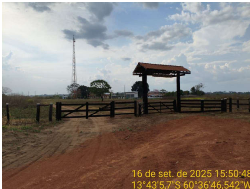
Foto 76 – Fim do trecho não pavimentado de MT-235.
