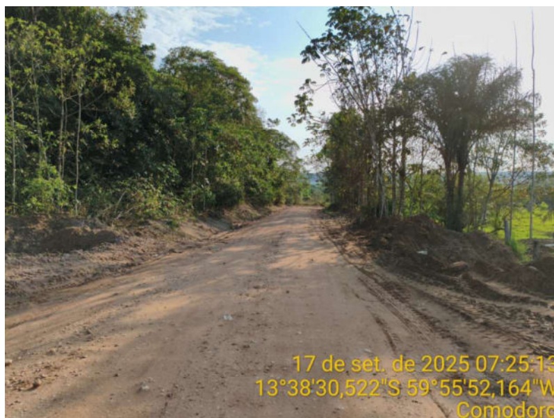
Foto 90 – Trecho não pavimentado da MT-440.
