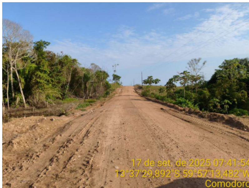
Foto 96 – Trecho não pavimentado da MT-440.
