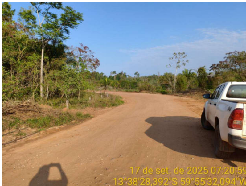
Foto 88 – Trecho não pavimentado da MT-440.
