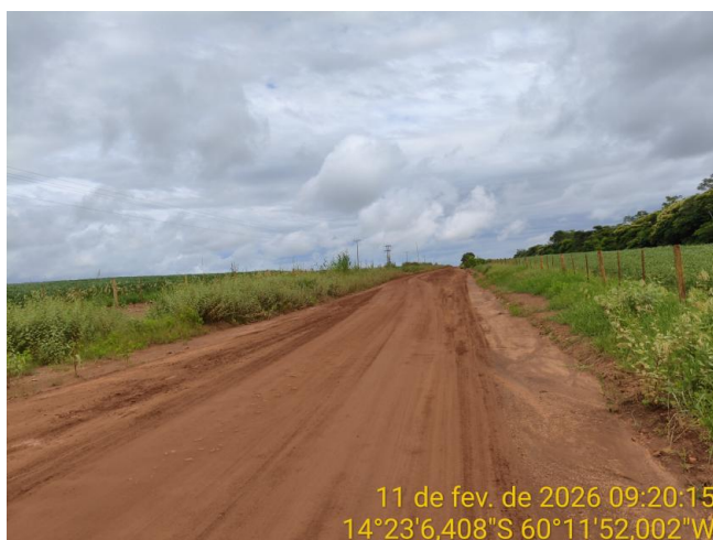
Foto 83 – Trecho não pavimentado da MT-199.
