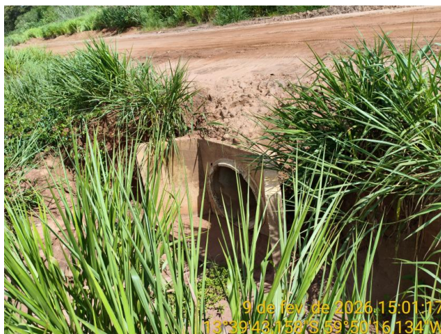
Foto 34 – Bueiro 01 na MT-440.
