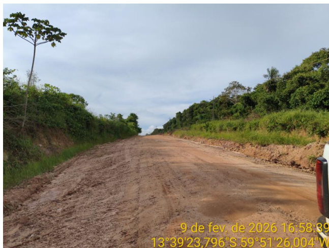
Foto 68 – Trecho não pavimentado da MT-440.
