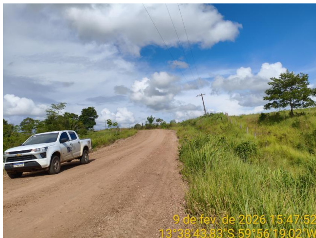
Foto 52 – Trecho não pavimentado de MT-440.
