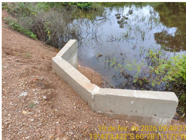
Foto 31 – Bueiro 01 no trecho não pavimentado MT-235.
