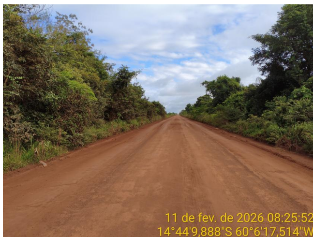
Foto 76 – Trecho não pavimentado da MT-199.
