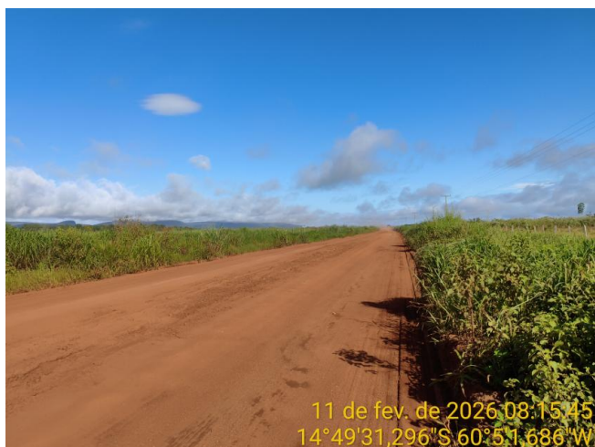
Foto 74 – Trecho não pavimentado da MT-199.
