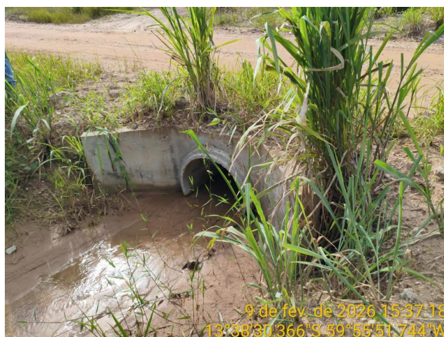
Foto 44 – Bueiro 04 (reconstruído) na MT-440 (cedida pela OSC). NOTIFICAÇÃO N° 019/2026/SAMAC/SAOR/SINFRA
