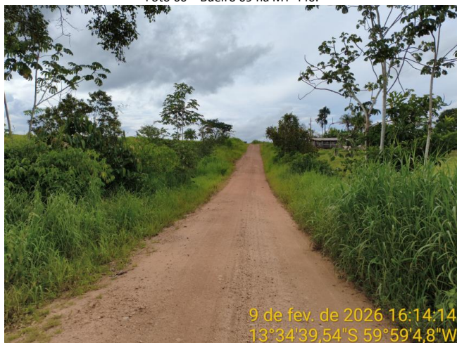
Foto 61 – Trecho não pavimentado da MT-440.
