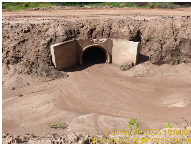
Foto 36 – Bueiro 02 na MT-440.
