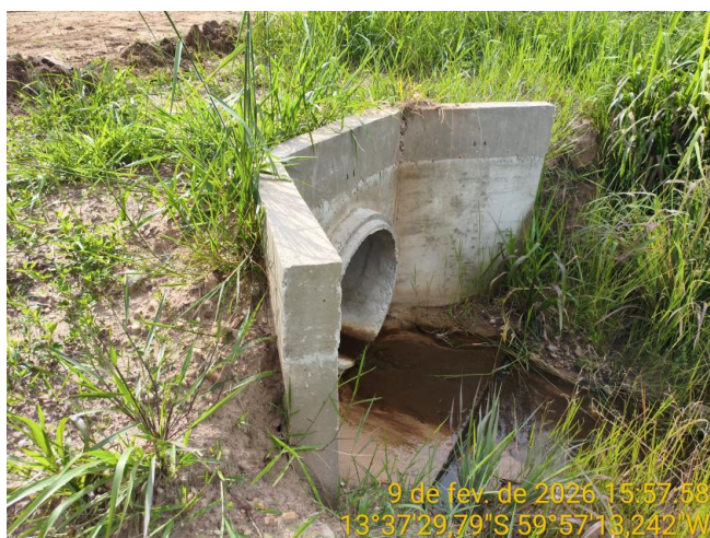
Foto 57 – Bueiro 06 na MT-440.
