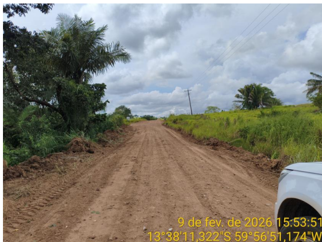
Foto 56 – Trecho não pavimentado de MT-240.
