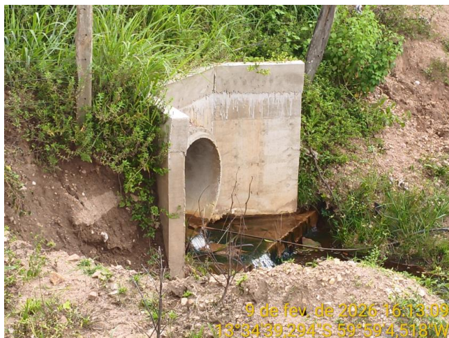
Foto 60 – Bueiro 09 na MT-440.
