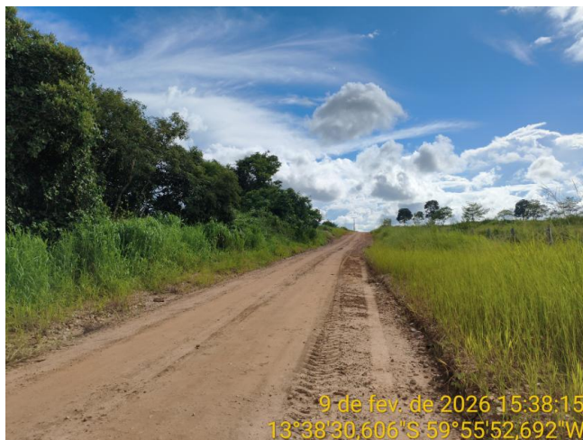
Foto 47 – Trecho não pavimentado de MT-240.
