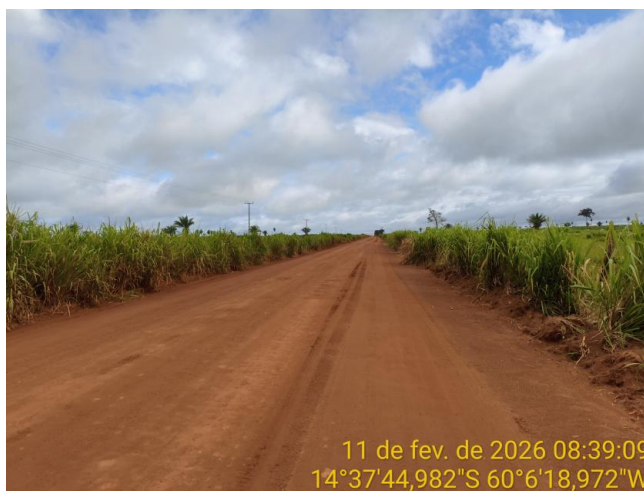
Foto 78 – Trecho não pavimentado da MT-199.
