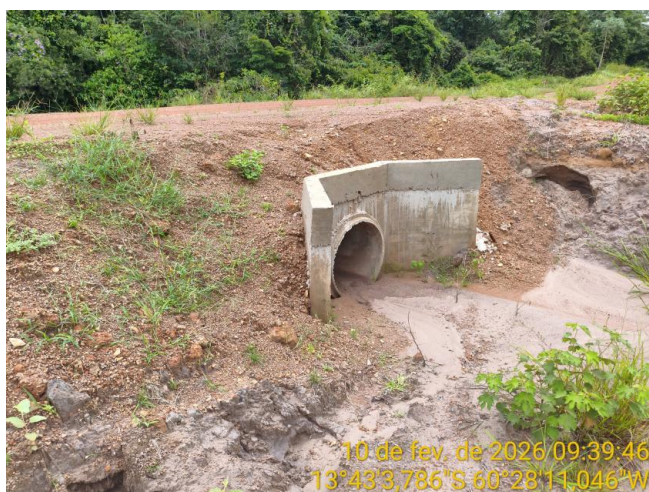
Foto 30 – Bueiro 01 no trecho não pavimentado MT-235.
