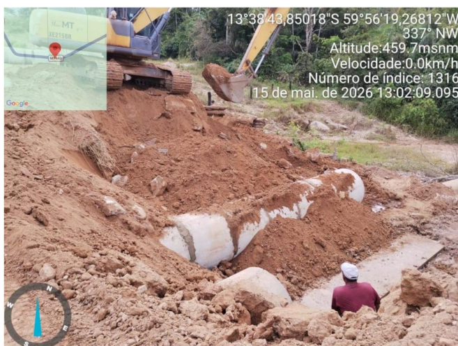
Foto 49 – Bueiro 07 (reconstrução) na MT-440 (cedida pela OSC). NOTIFICAÇÃO N° 019/2026/SAMAC/SAOR/SINFRA
