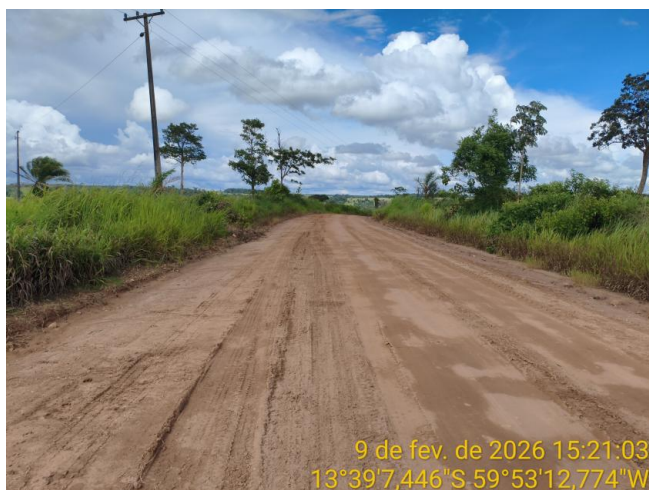
Foto 41 – Trecho não pavimentado de MT-440.
