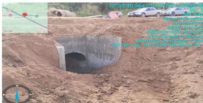
Foto 43 – Bueiro 04 (reconstruído) na MT-440 (cedida pela OSC). NOTIFICAÇÃO N° 019/2026/SAMAC/SAOR/SINFRA
