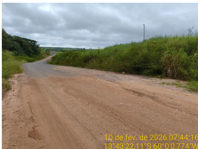
Foto 01 - Início do trecho não pavimentado MT-235.
