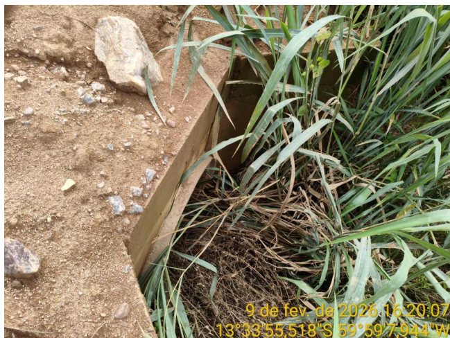
Foto 64 – Bueiro 10 na MT-440.
