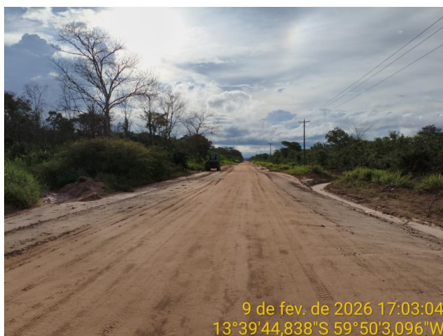
Foto 69 – Trecho não pavimentado da MT-440.
