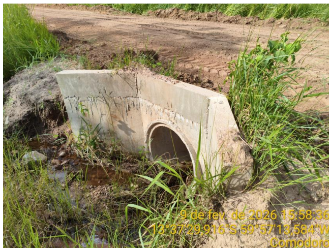
Foto 58 – Bueiro 06 na MT-440.
