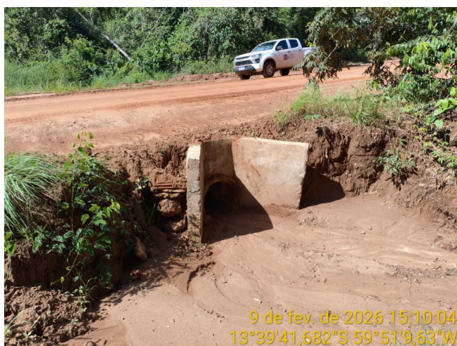
Foto 38 – Bueiro 03 na MT-440.
