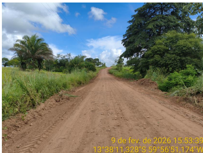
Foto 55 – Trecho não pavimentado de MT-440.
