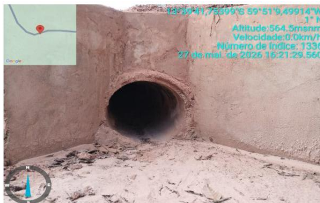
Foto 39 – Reparos no bueiro 03 na MT-240 (cedida pela OSC). NOTIFICAÇÃO N° 019/2026/SAMAC/SAOR/SINFRA
