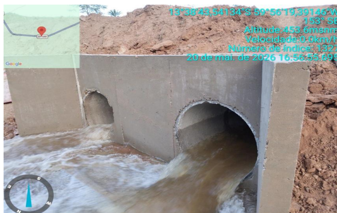
Foto 50 – Bueiro 07 (reconstrução) na MT-440 (cedida pela OSC). NOTIFICAÇÃO N° 019/2026/SAMAC/SAOR/SINFRA
