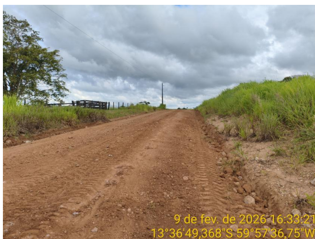
Foto 65 – Trecho não pavimentado da MT-440.
