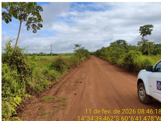
Foto 80 – Trecho não pavimentado da MT-199.
