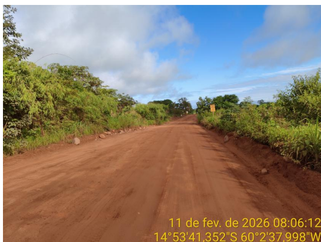
Foto 73 – Trecho não pavimentado da MT-199.
