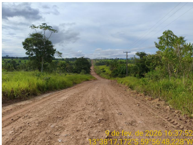
Foto 66 – Trecho não pavimentado da MT-440.
