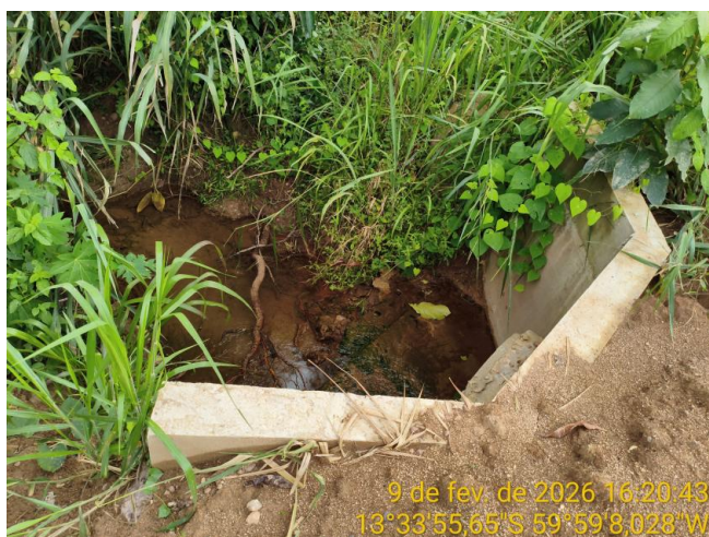
Foto 63 – Bueiro 10 na MT-440.
