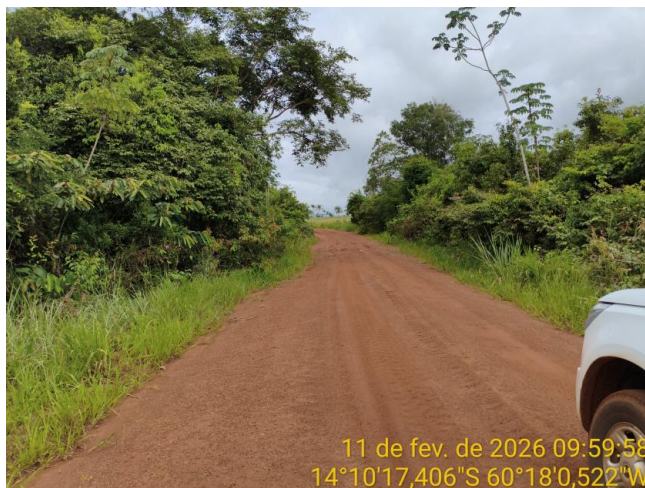
Foto 84 – Trecho não pavimentado da MT-199.
