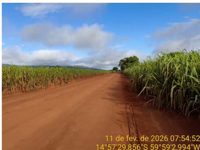
Foto 72 – Trecho não pavimentado da MT-199.
