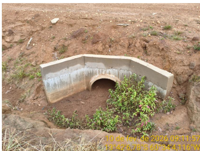
Foto 24 – Bueiro 02 no trecho não pavimentado MT-235.
