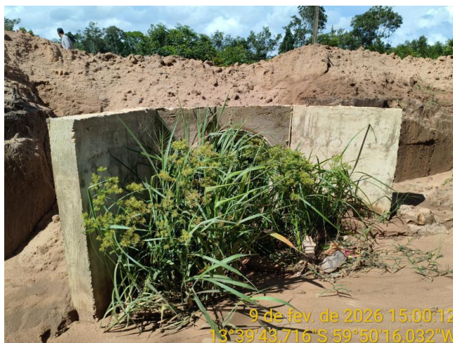
Foto 33 – Bueiro 01 na MT-440.
