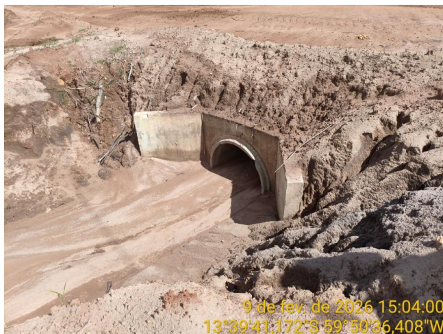
Foto 35 – Bueiro 02 na MT-440.
