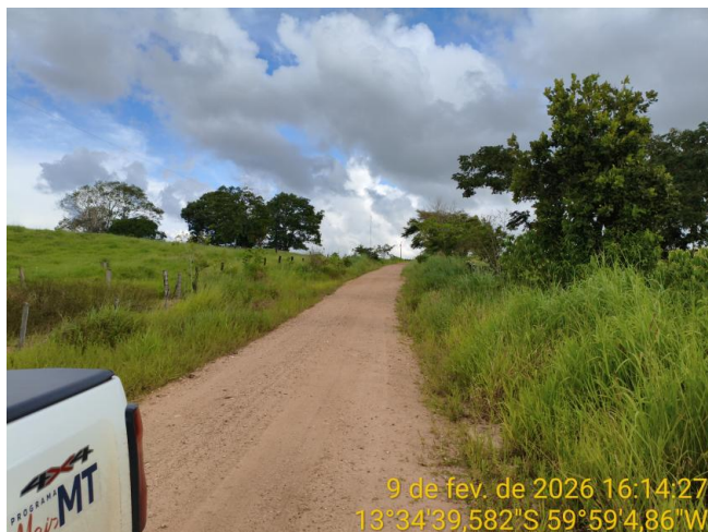
Foto 62 – Trecho não pavimentado da MT-440.
